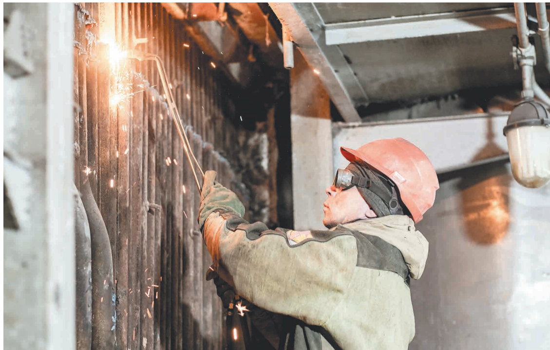
← Демонтаж экранных труб.
