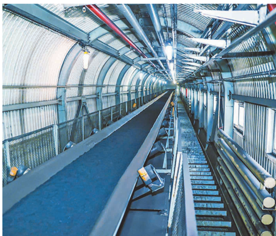
↑ Обновлено оборудование конвейеров.
