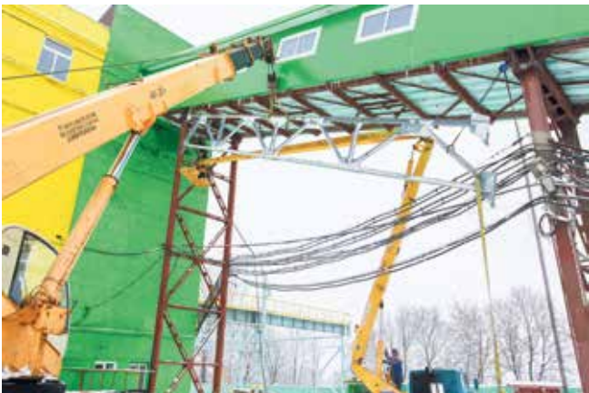
Монтаж металлической фермы
