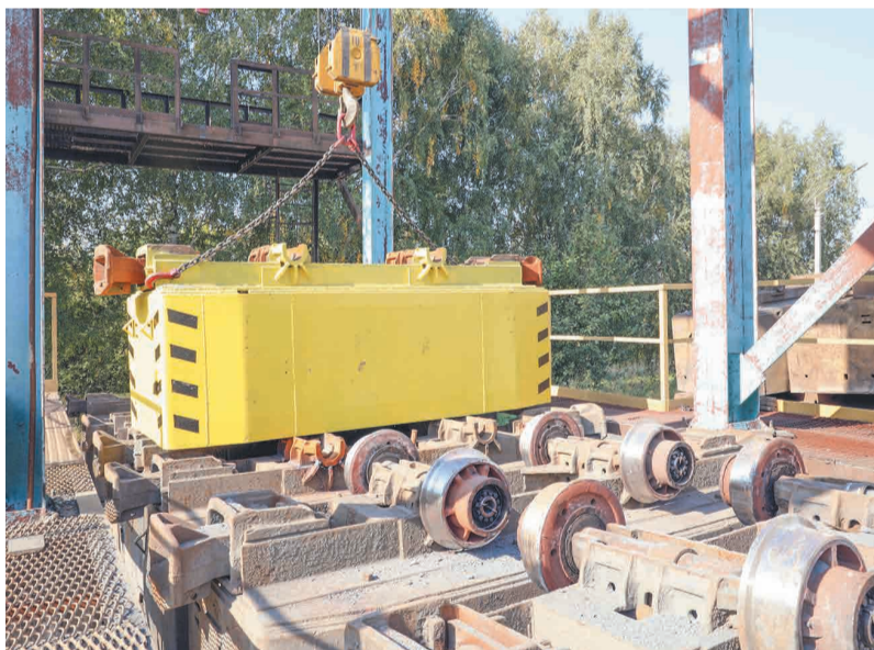
↑ Монтаж нового корпуса вагонетки ВГ-4,5.
