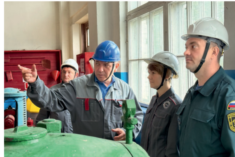
С улучшениями в здании подъемной машины ствoла №1 знакомит начальник участка №7 шахты Алексей Беликов.
