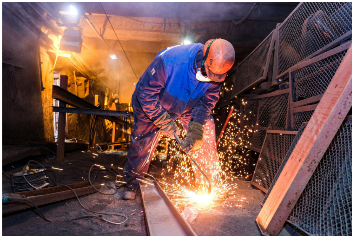
Ремонтный персонал агломерационного цеха и ЦКРО заменил 10 тонн металлоконструкций и 260 метров конвейерной ленты.
