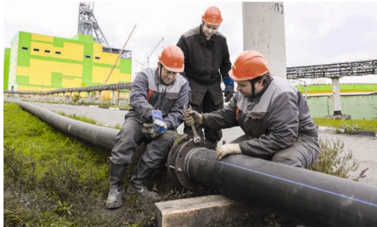
Слесари по обслуживанию и ремонту оборудования Евгений Зайцев, Сергей Герасимов (слева направо) и электрогазосварщик Денис Чуриков (в центре) монтируют напорный пульпопровод
