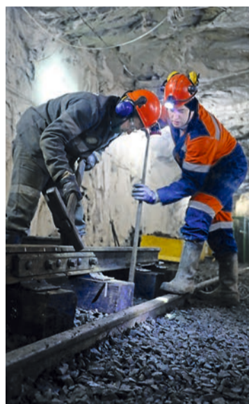
Зашивка рельс с помощью молотка и лапы.
