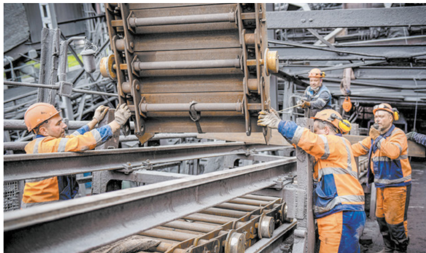
Демонтаж и монтаж конвейера выполнили сами сотрудники Тулачермета.
