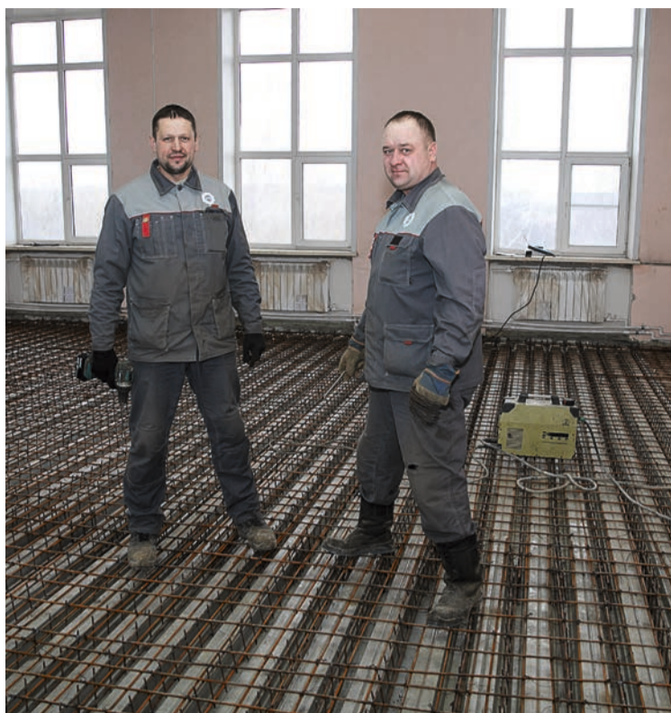
Монтажники РСЦ Сергей Харьков (слева) и Андрей Дмитриев на подготовительных работах по заливке пола
