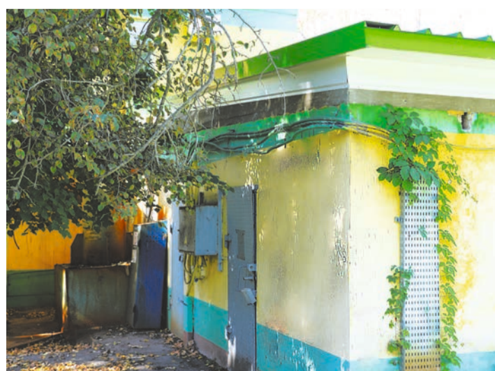
Кровля – лишь первый этап ремонта.
