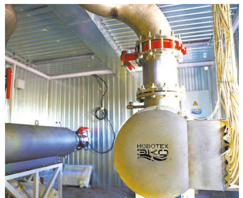
УФ-излучатель – экологичный контролер обеззараживания.
