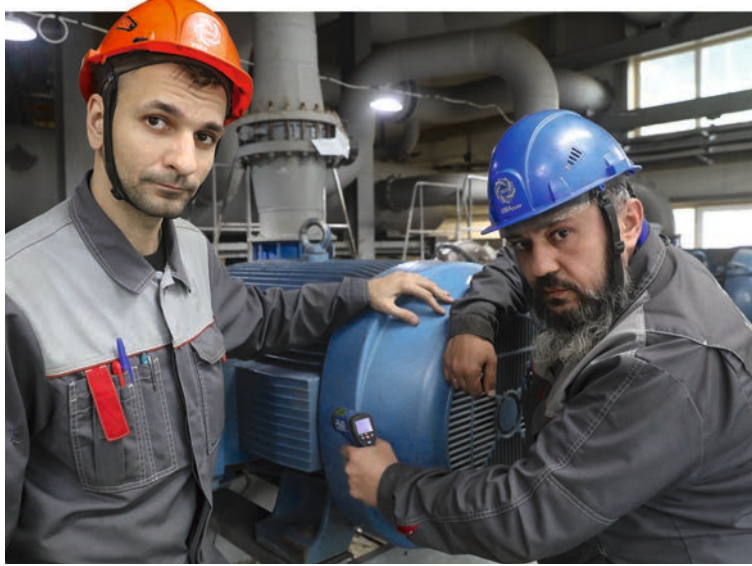
Андрей Голубятников (слева) и Алексей Топоров контролируют нагрев подшипникового узла электродвигателя
