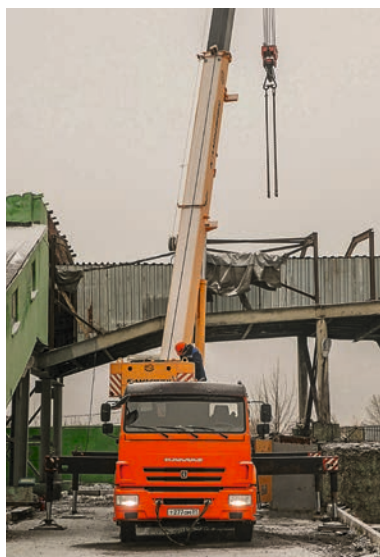
Ремонтируется галерея ЛК № 20
