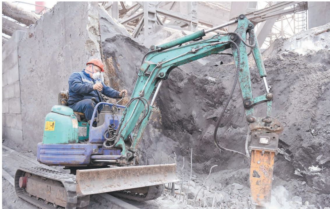
← Ремонт переваль- ной стены.
