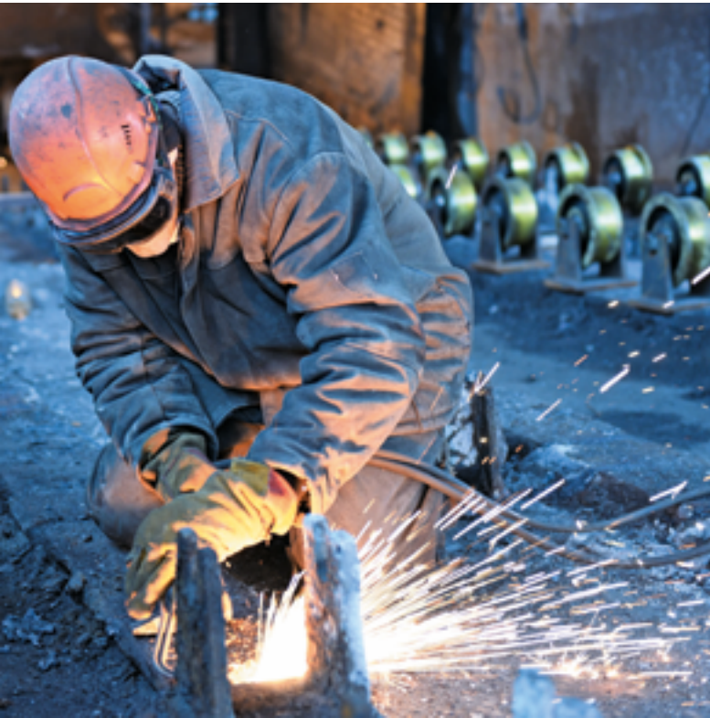
Монтаж опор роликов.
