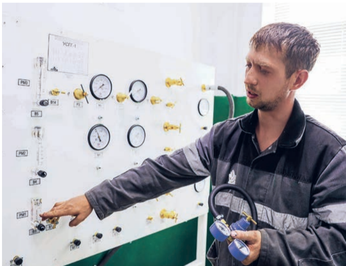
Наладчик газопламенного оборудования Денис Михнев объясняет работу нового стенда.
