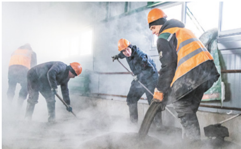
Бригада выполняет работы по бетонированию галерей.
